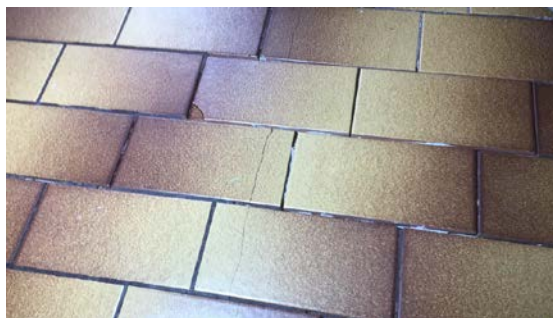
Knekte/sprekte fliser i gang
