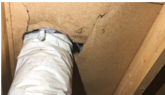
Utettheter rundt gjennomføring i undertak
