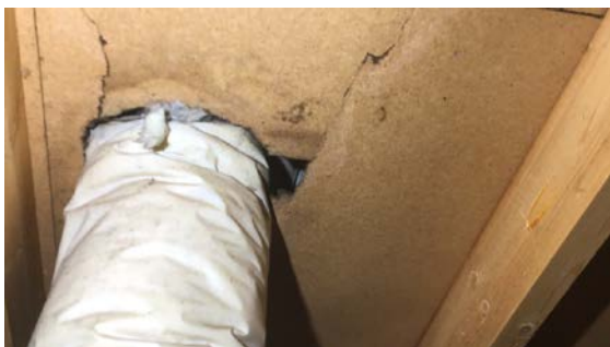
Utettheter rundt gjennomføring i undertak
