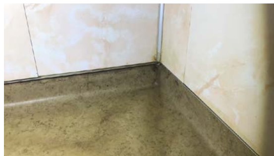
Fuktskader i nedkant våtromsplater i dusj
