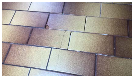
Knekte/sprekte fliser i gang
