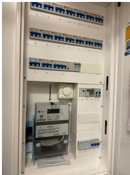
Sikringsskap med automatsikringer.
