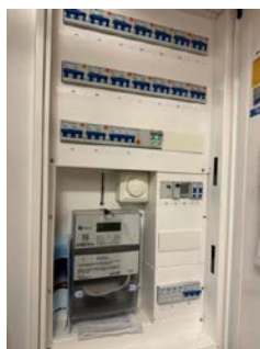
Sikringsskap med automatsikringer.
