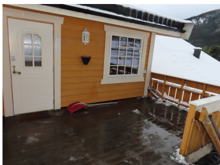
Åpent terrasseareal i forbindelse med inngangspartiet.
