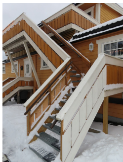
Trapp fra terreng som plassbygd. Stekkmestall i trinn.
