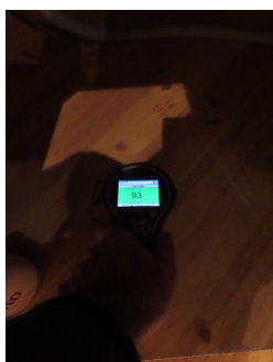
Fuktsøk i benkeskap - ingen påviste forhøyede fuktverdier.
