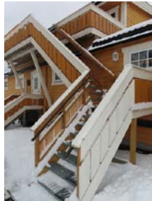
Trapp fra terreng som plassbygd. Stekkmetsall i trinn.
