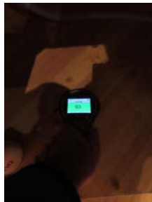
Fuktsøk i benkeskap - ingen påviste forhøyede fuktverdier.
