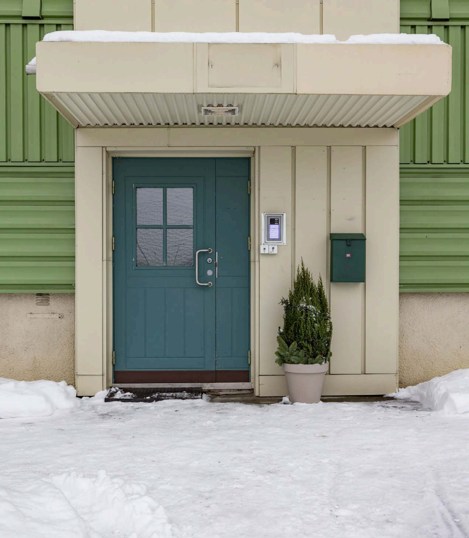
Overbygget inngangsparti. Borettslaget fikk montert nytt porttelefonlegg i 2019.
