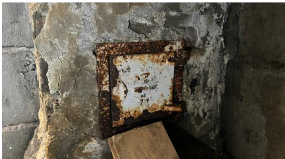
Sotluken holdes igjen med kledningsbord.
