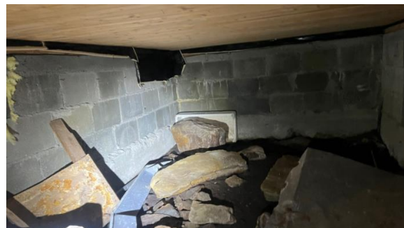
Oversiktsbilde av el av krypekjelleren
