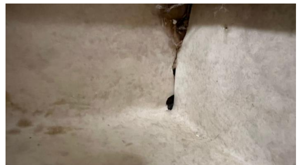
Eksempel på utett belegg
