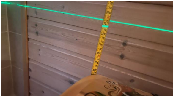
Høyde måling ved pipen på loftet
