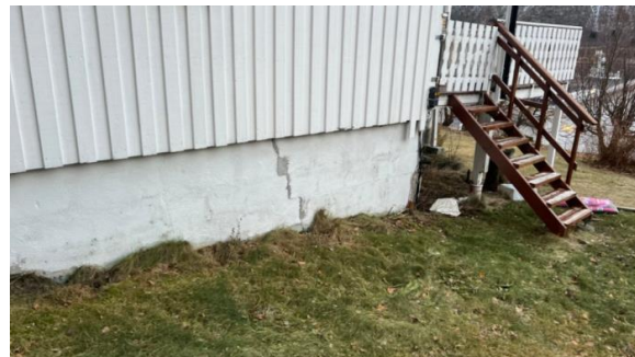
Manglende rekkverk på trappen.
