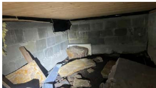
Oversiktsbilde av et av krypekjelleren
