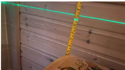
Høyde måling ved pipen på loftet
