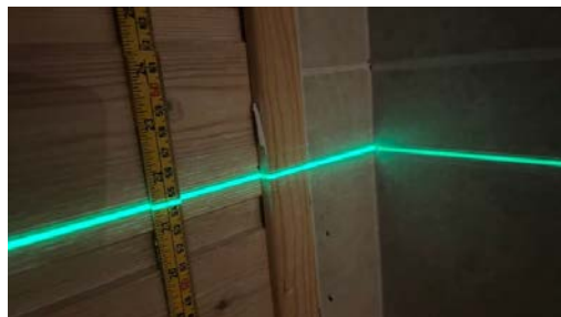
Høydemåling ved pipen på loftet
