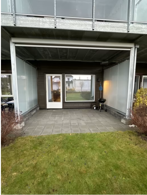
Uteplass med adkomst fra stue og terreng.
