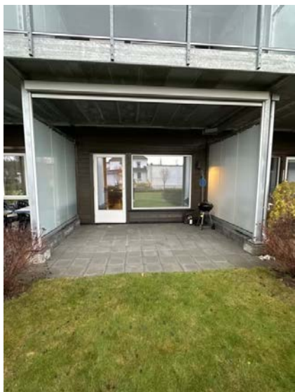
Uteplass med adkomst fra stue og terreng.
