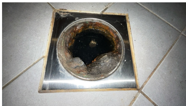
Kontroll av sluk.
