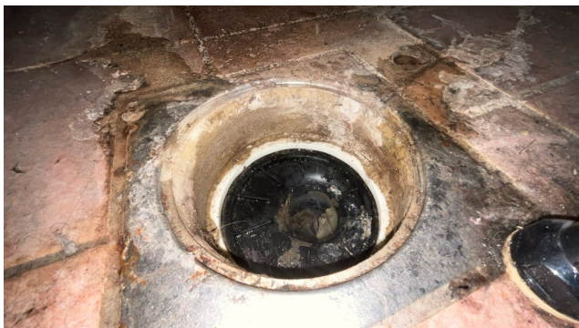
Kontroll av sluk.
