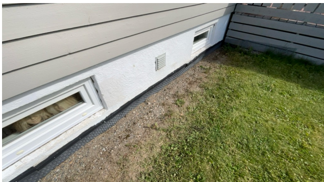
Kontroll av drenering/fuktsikring.
