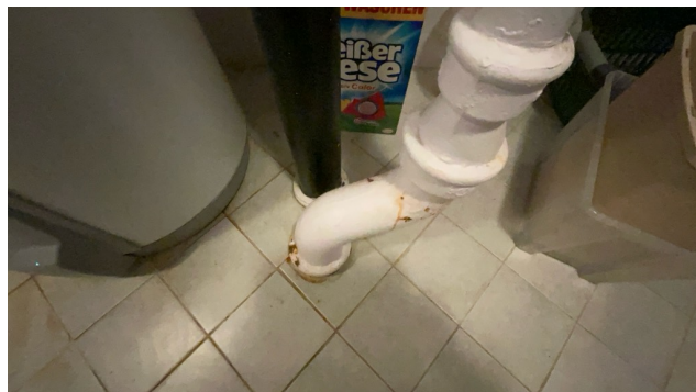
Synlig soilrør ned i grunn.
