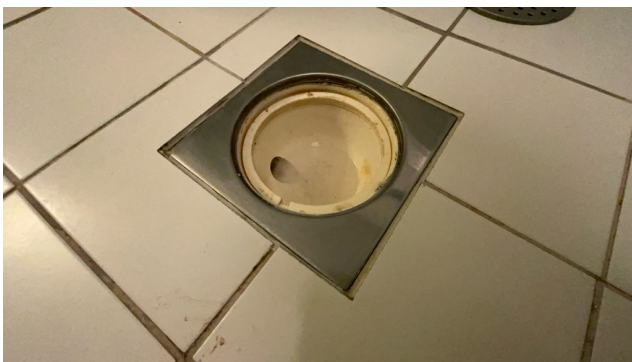
Kontroll av sluk.
