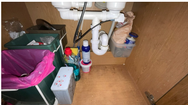
Besiktigelse av røropplegg.
