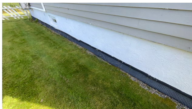
Kontroll av drenering/fuktsikring.
