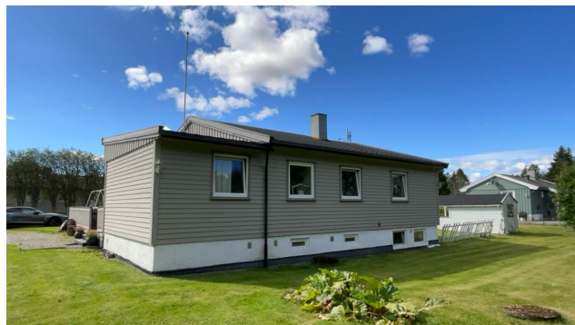
Besiktigelse av taktekke.
