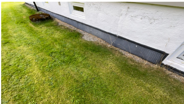
Kontroll av drenering/fuktsikring.
