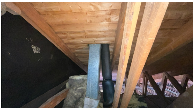
Kontroll rundt rørgjennomføringer.
