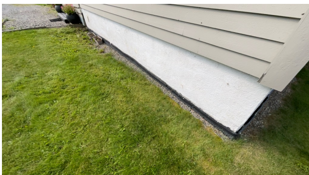
Kontroll av drenering/fuktsikring.
