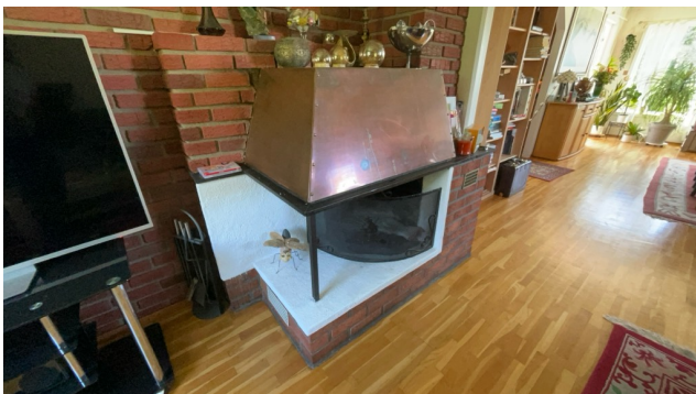
Besiktigelse av ildsted.
