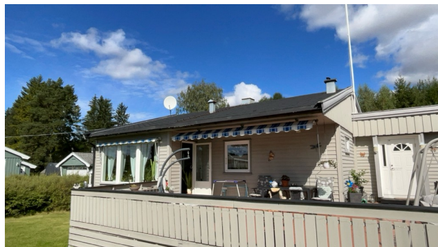
Besiktigelse av taktekke.
