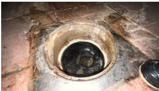
Kontroll av sluk.
