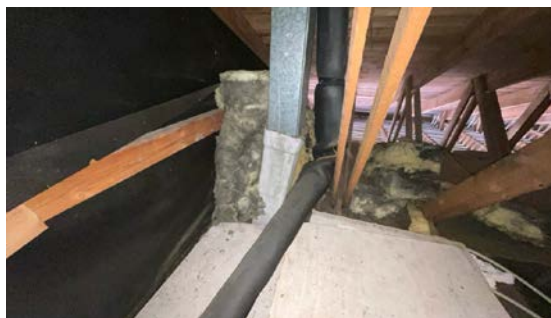
Synlig kanal av eternitt
