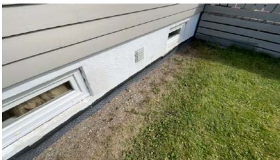
Kontroll av drenering/fuksikring.
