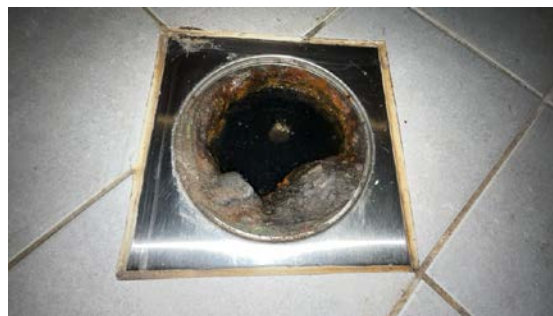
Kontroll av sluk.
