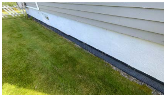
Kontroll av drenering/fuktsikring.
