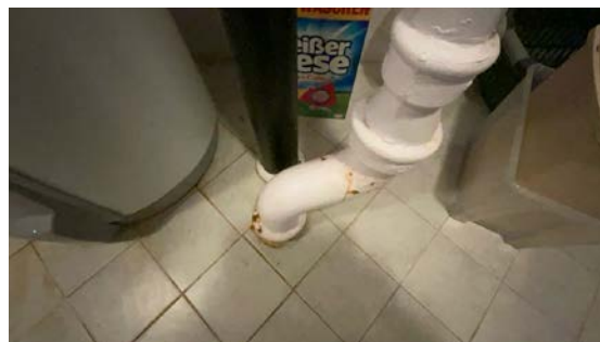
Synlig soilrør ned i grunn.
