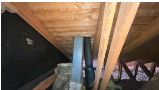
Kontroll rundt rørgjennomføringer.
