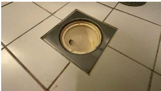
Kontroll av sluk.
