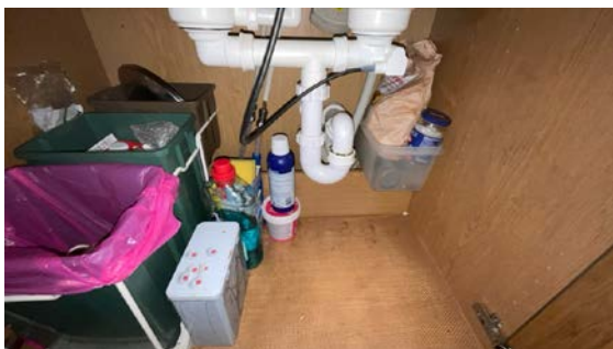
Besiktigelse av røropplegg.
