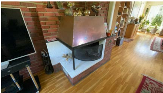
Besiktigelse av ildsted.
