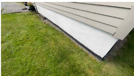
Kontroll av drenering/fuksikring.
