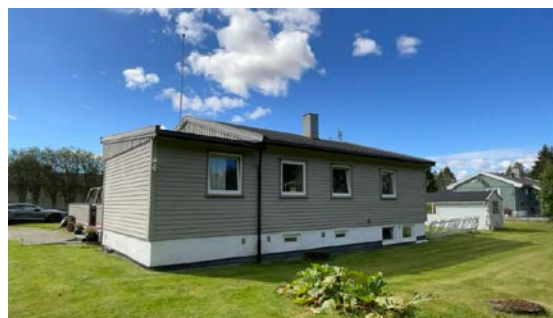
Besiktigelse av taktekke.
