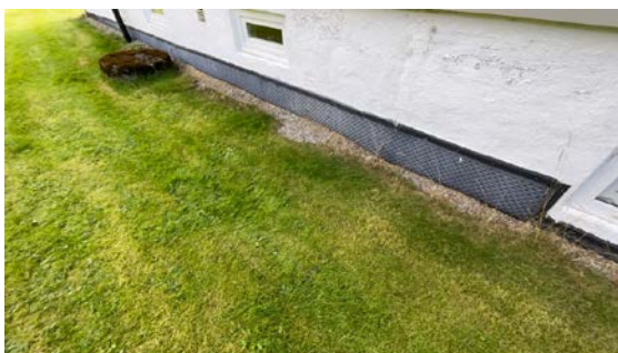
Kontroll av drenering/fuksikring.
