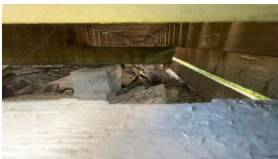
Kontroll av fundament. Kommende behov for utbedringer kan ikke utelukkes på sikt.
