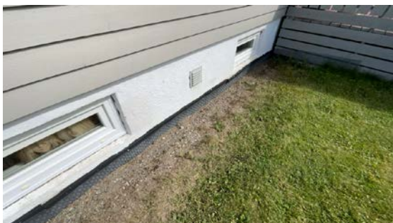
Kontroll av drenering/fuksikring.
