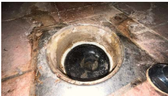
Kontroll av sluk.
