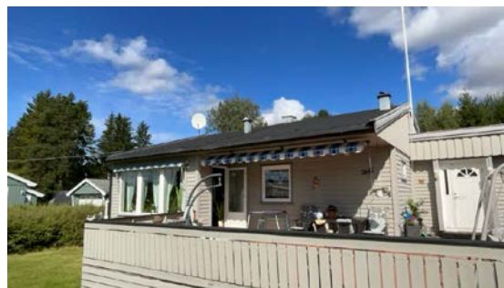
Besiktigelse av taktekke.
