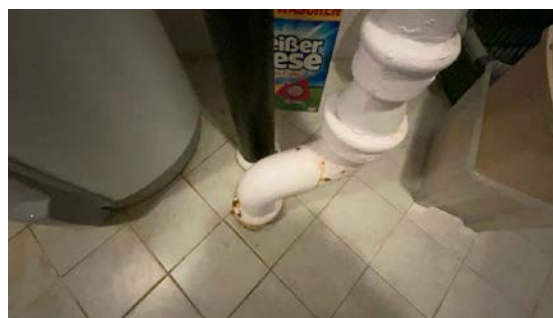
Synlig soilrør ned i grunn.
