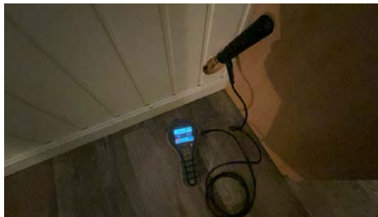
Utført hulltaking på rom under terreng.
