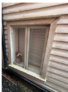
Vindu på loft med sprekk i glass.
