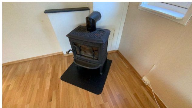
Besiktigelse av ildsted.
