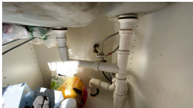
Besiktigelse av rørøpplegg.
