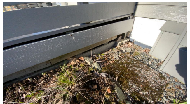
Kontroll av fundament.
