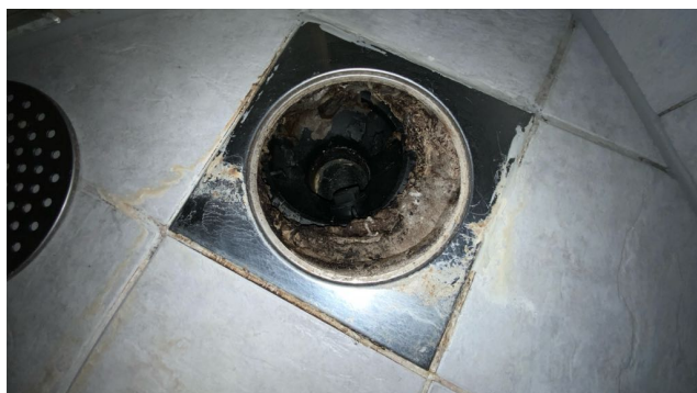
Kontroll av sluk.
