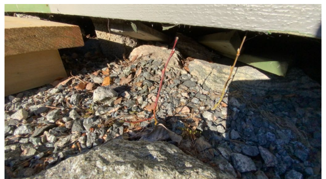
Kontroll av fundament.
