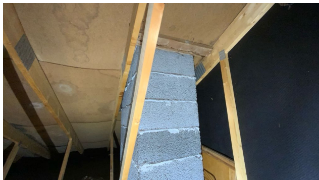
Kontroll rundt pipeløp.
