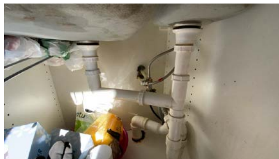
Besiktigelse av rørøpplagg.
