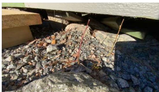
Kontroll av fundament.
