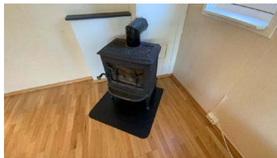
Besiktigelse av ildsted.
