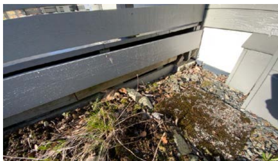
Kontroll av fundament.
