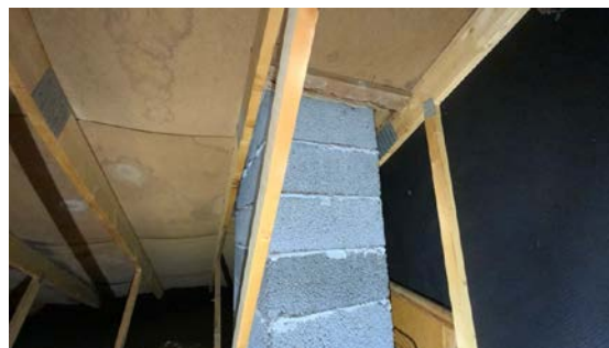
Kontroll rundt pipeløp.
