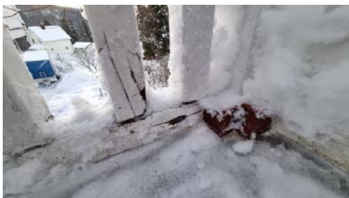
Det er råteskader i rekkverk.
