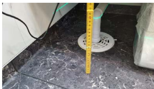
Kontroll av fall til sluk.
