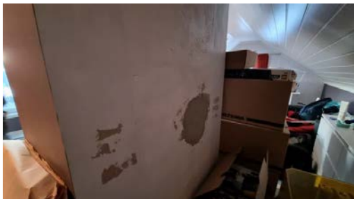
Tetting av hull i pipeløp.
