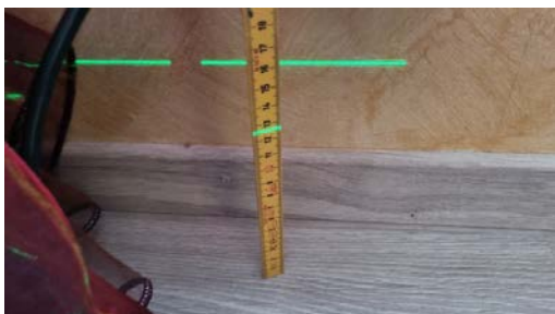
Kontroll av planavvik.
