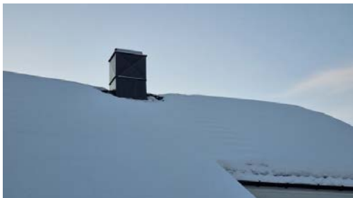
Taket var ved befaring dekket av snø.
