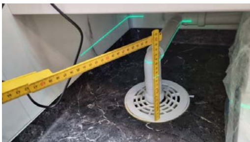
Kontroll av fall til sluk.
