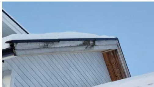
Kassebord er ikke overflatebehandlet.
