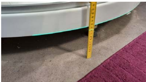
Kontroll av fall til sluk.
