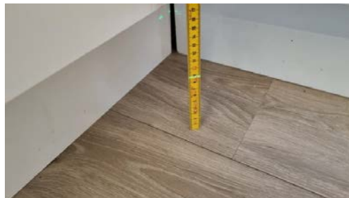
Kontroll av planavvik.
