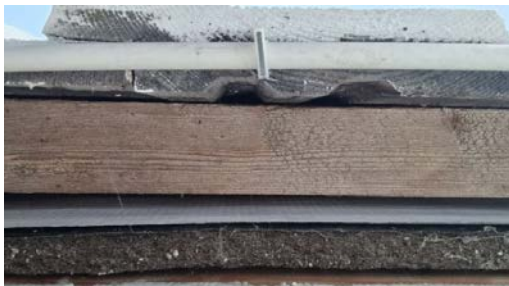
Det mangler klemlekter og musebånd i nedre kant av konstruksjonen.
