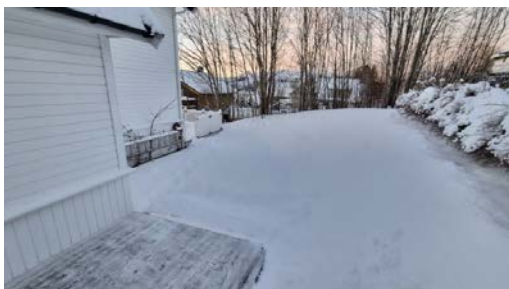
Eier opplyser om at det er gjort justeringer i terreng for å lede vann bort fra bygningskroppen.
