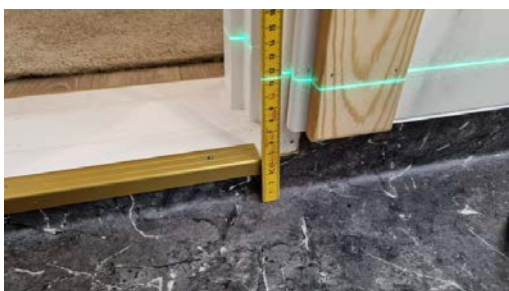
Kontroll av fall til sluk.
