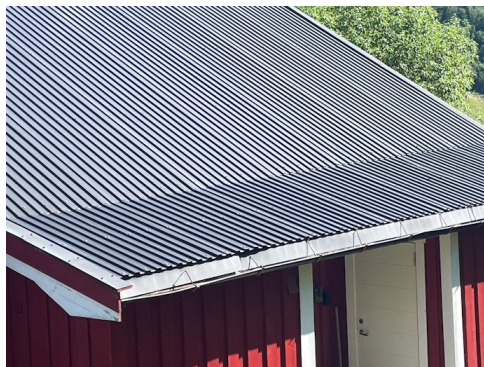
Utett overgang i takteking
