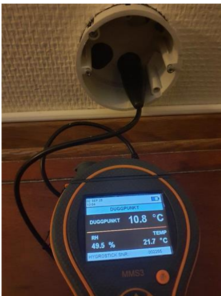
Våtrom - [Fuktmåling i vegg mot bad 204 A, utført fra soverom.]
