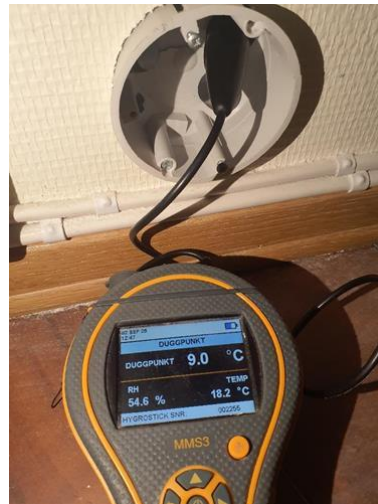
Våtrom - [Fuktmåling i vegg mot dusjsone bad 204, utført fra kjøkken.]
