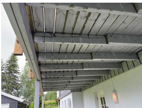
Drager og bjelker til veranda.
