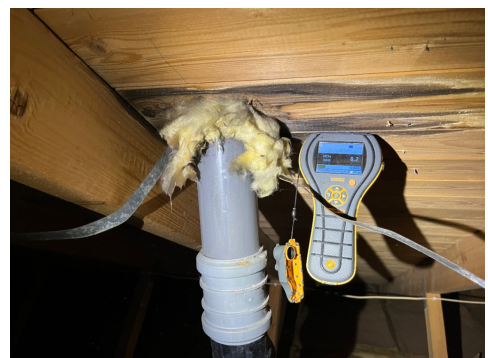
Fuktmåling ved gjennomføring av lufting viste normale verdier.
