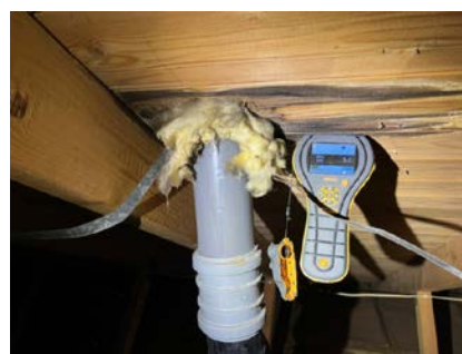
Fuktmåling ved gjennomføring av lufting viste normale verdier.
