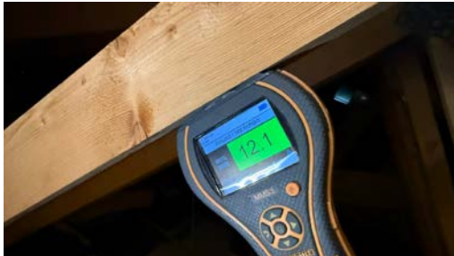
Fuktmåling i sperre
