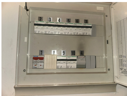
Sikringsskap med automatsikringer.
