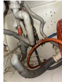
Rørroplegg i kjøkkenbenk med Waterguard
