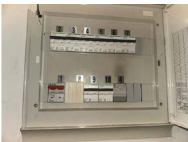
Sikringsskap med automatsikringer.
