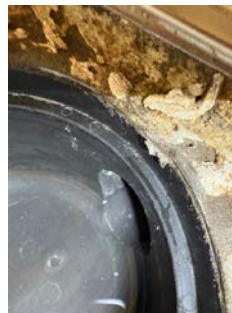
Mansjett/smøremembran under klemring
