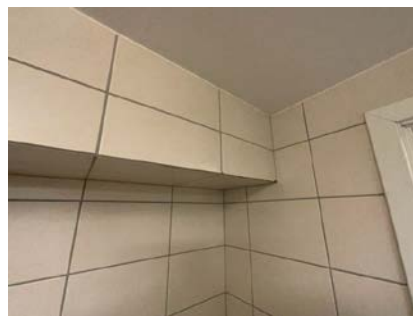
Sprekk i flis ved fordelingskap.
