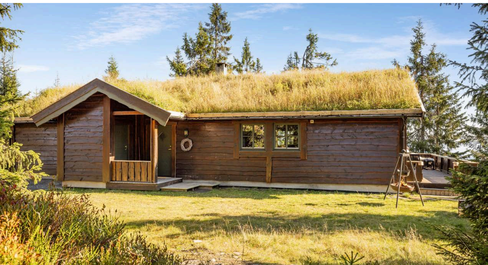
Hytta ble oppgradert i 2024 med nye takrenner og nedløp, samt nye terrassegulv på terrassen.
