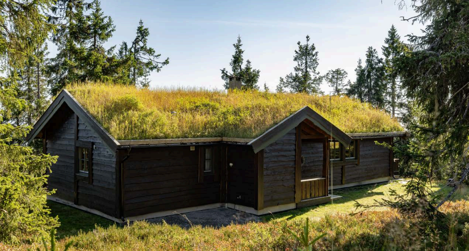
Flott hytte fra 2002 med yttervegger kledd med villmarkspanel og tak tekket med torv.
