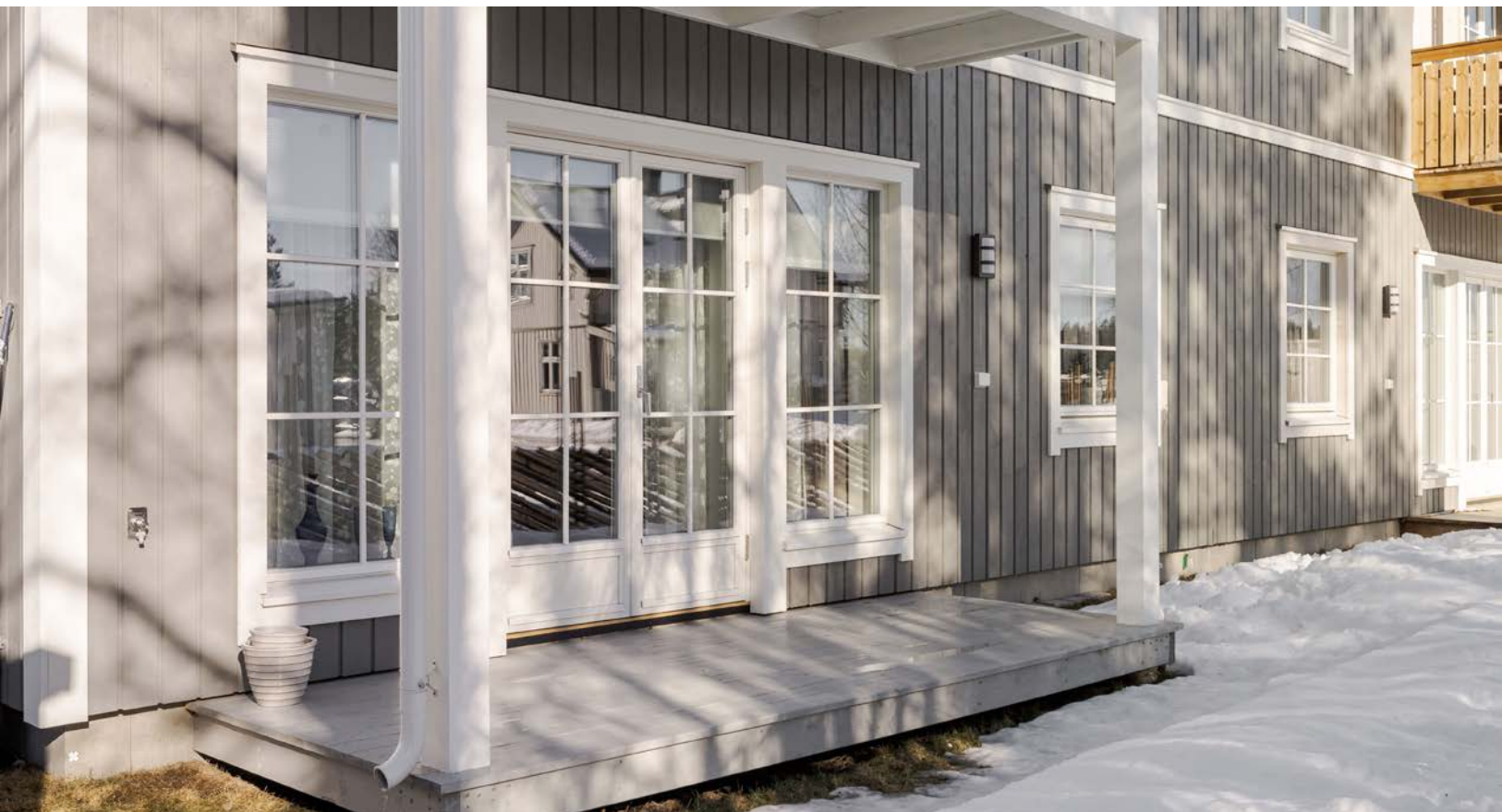
Terrassen er overbygget og har terrassebord på gulv. Det er også montert utebelysning, utvendig stikkontakt og utekran.
