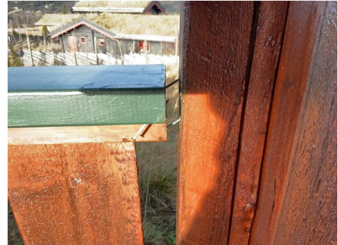
Utsig av terrasse/rekkverk
