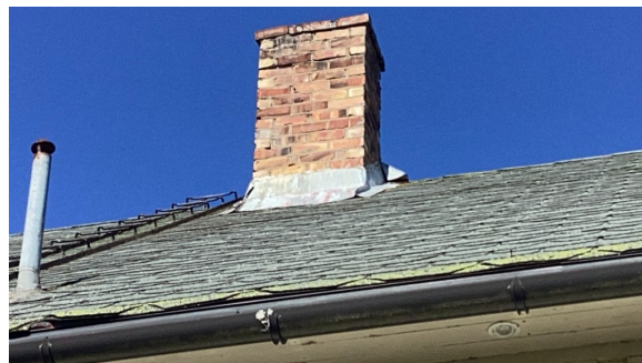
Overgangsbeslag rundt pipe av bly.
