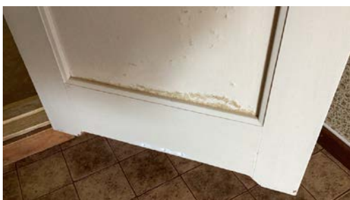
Eksempel på slitasje på dør.
