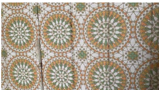
Eksempel på slitasje/avvik.
