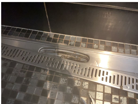
Slukrenne ved vegg.
