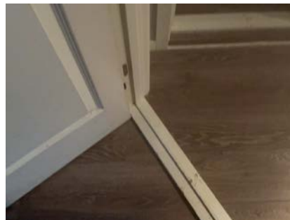
Bie skitasje og spr på karmen og terskel.
