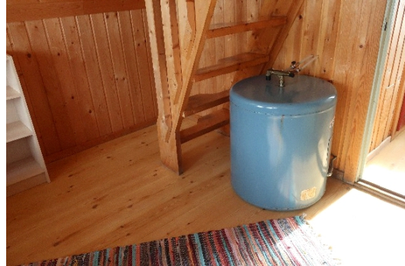
Varmtvannsbereeder.
