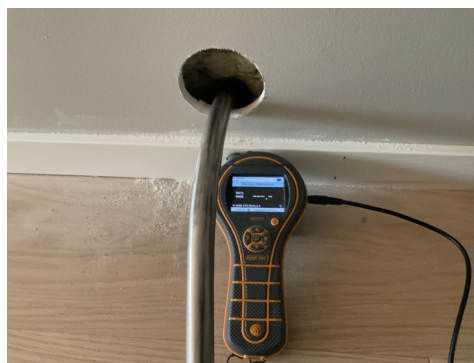
Fuktmåling mot dusjhjørne 09.02.2026
