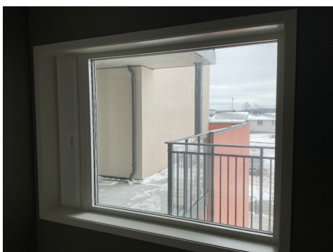
Soveromsvinduet med luftfelt.
