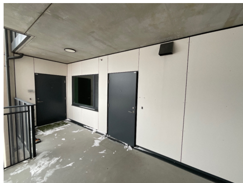
Inngangsdør, soveromsvindu og utvendig platekledning.
