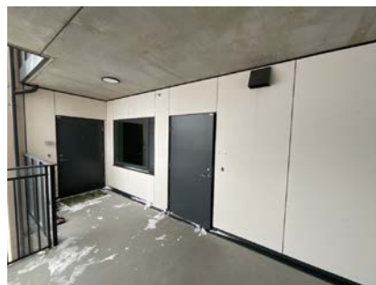
Inngangsdør, soveromsvindu og utvendig platekledning.
