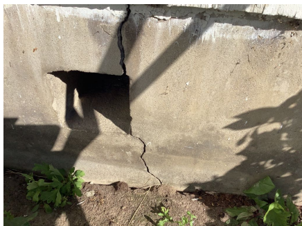
Bildene viser sprekkdannelser i ringmuren.
