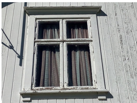
Bildene viser eksempler på værslitte vinduer.
