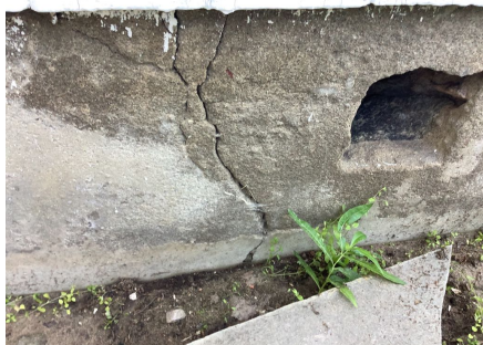
Bildene viser sprekkdannelser i ringmuren.
