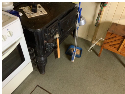
Bildet viser at det mangler ildfast plate på gulv foran ildsted.
