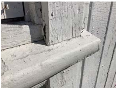
Bildet viser at omramming rundt vindu er ført helt ned til vannbrett.
