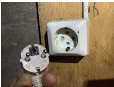
Bildet viser utilfredsstillende el-tilkobling iht. gjeldende forskrift.
