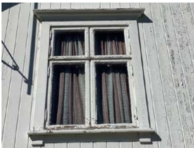
Bildene viser eksempler på værslitte vinduer.
