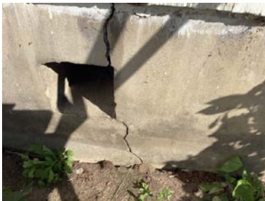
Bildene viser sprekkdannelser i ringmuren.
