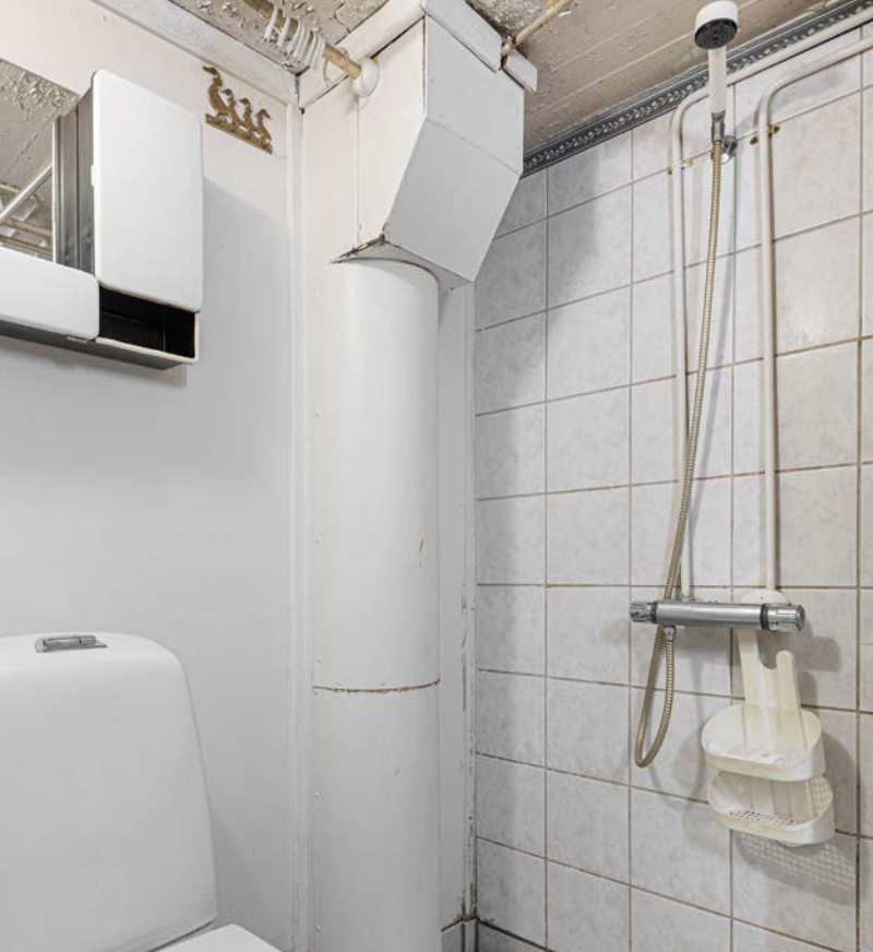
Flislagt bad med gulvvarme.
