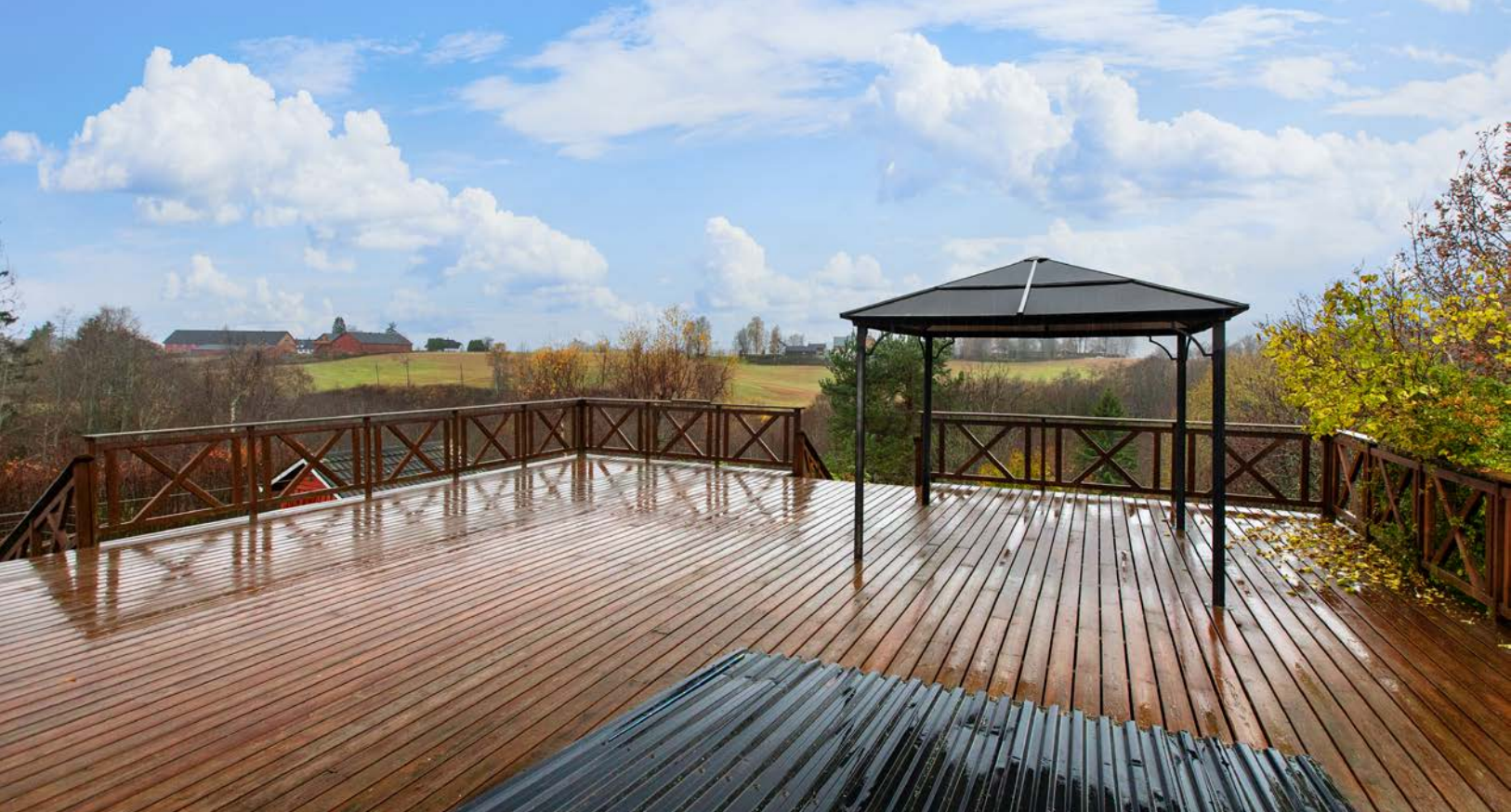
Stor og solrik terrasse. Terrassen er ikke byggemeldt.
