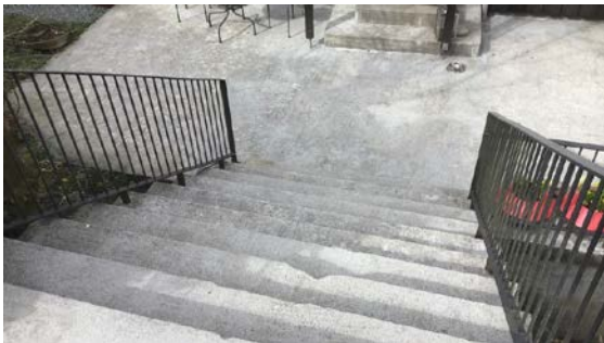
Trapp ved inngang
