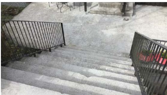
Trapp ved inngang
