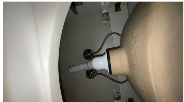
Del av rør til vann.
