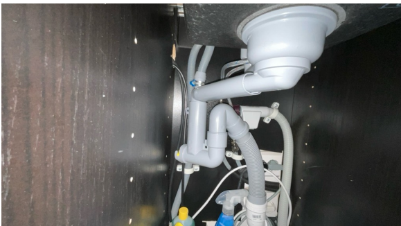
Del av rør til vann.
