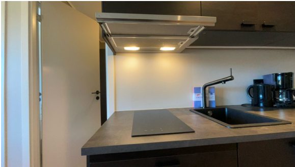
Montert avtrekk over steketopp.
