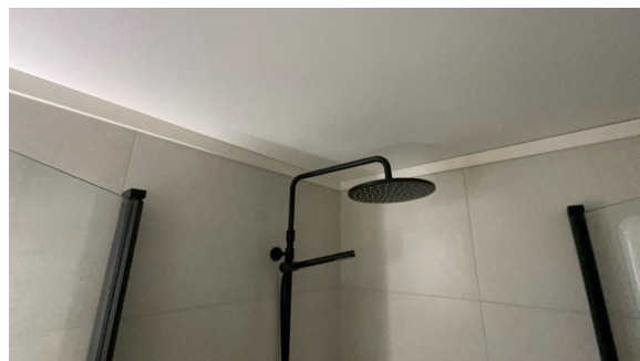
Del av vegg - tak.
