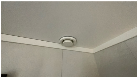
Montert avtrekk i tak.
