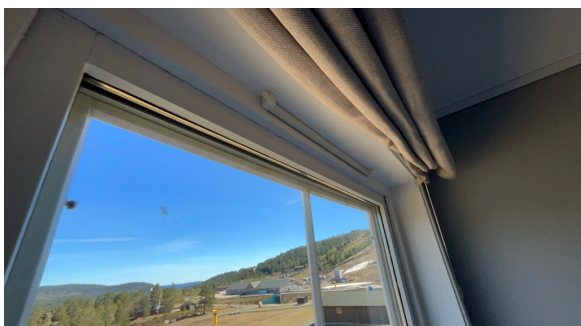
Eksempel på montert ventil i vindu.
