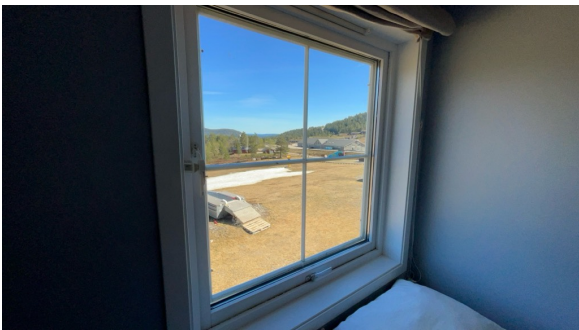
Eksempel på vindu i yttervegg.
