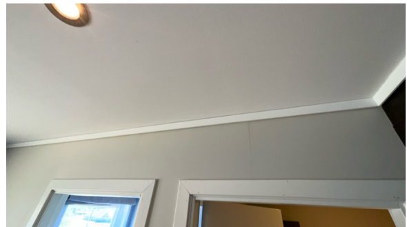
Del av vegg - tak.
