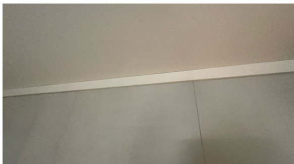
Del av vegg - tak.
