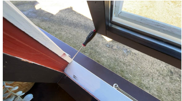
Stikkontroll på vinduer er utført.
