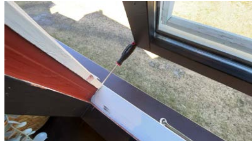
Stikkontroll på vinduer er utført.
