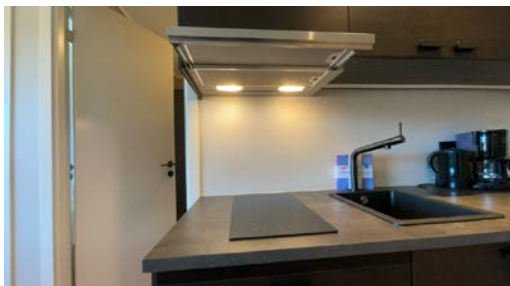
Montert avtrekk over steketopp.
