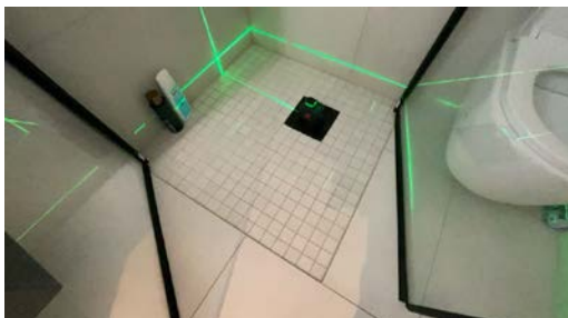
Målt fall på gulv.
