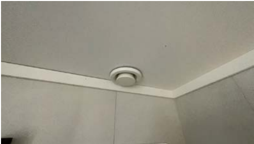
Montert avtrekk i tak.
