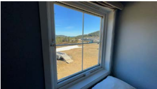
Eksempel på vindu i yttervegg.
