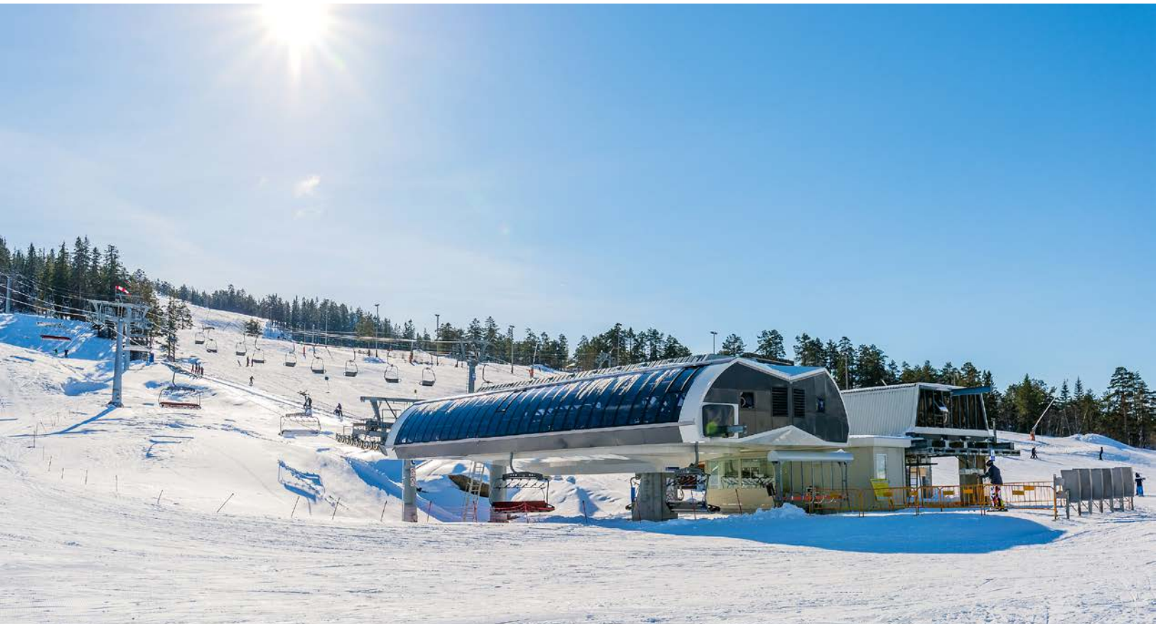
Alpinanlegget på Gautefall er oppgradert med moderne ekspressheis med 6 stoler, og i dag består anlegget av 14 nedfarter, 2 stolheiser og 3 skitrek.
