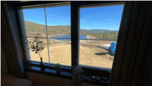
Eksempel på vindu i yttervegg.
