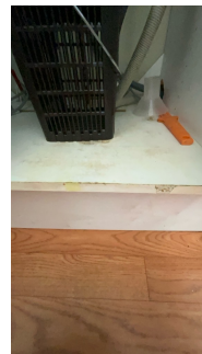
Fuktskjolder/svelling i bunnplate i benkeskap.
