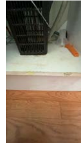
Fuktskjolder/svelling i bunnplate i benkeskap.
