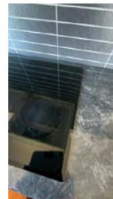
Fuktskjolder/svelling i bunnplate i benkeskap.
