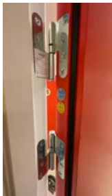
Ytterdør med brann/lydmotstand.
