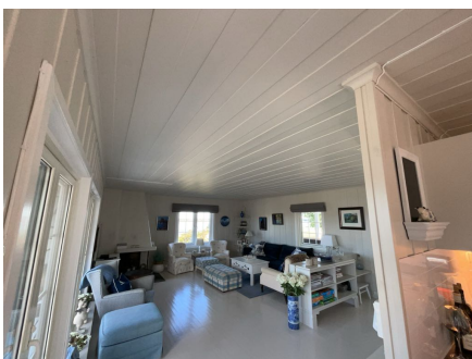
Utsnitt gjenbygd takkonstruksjon.
